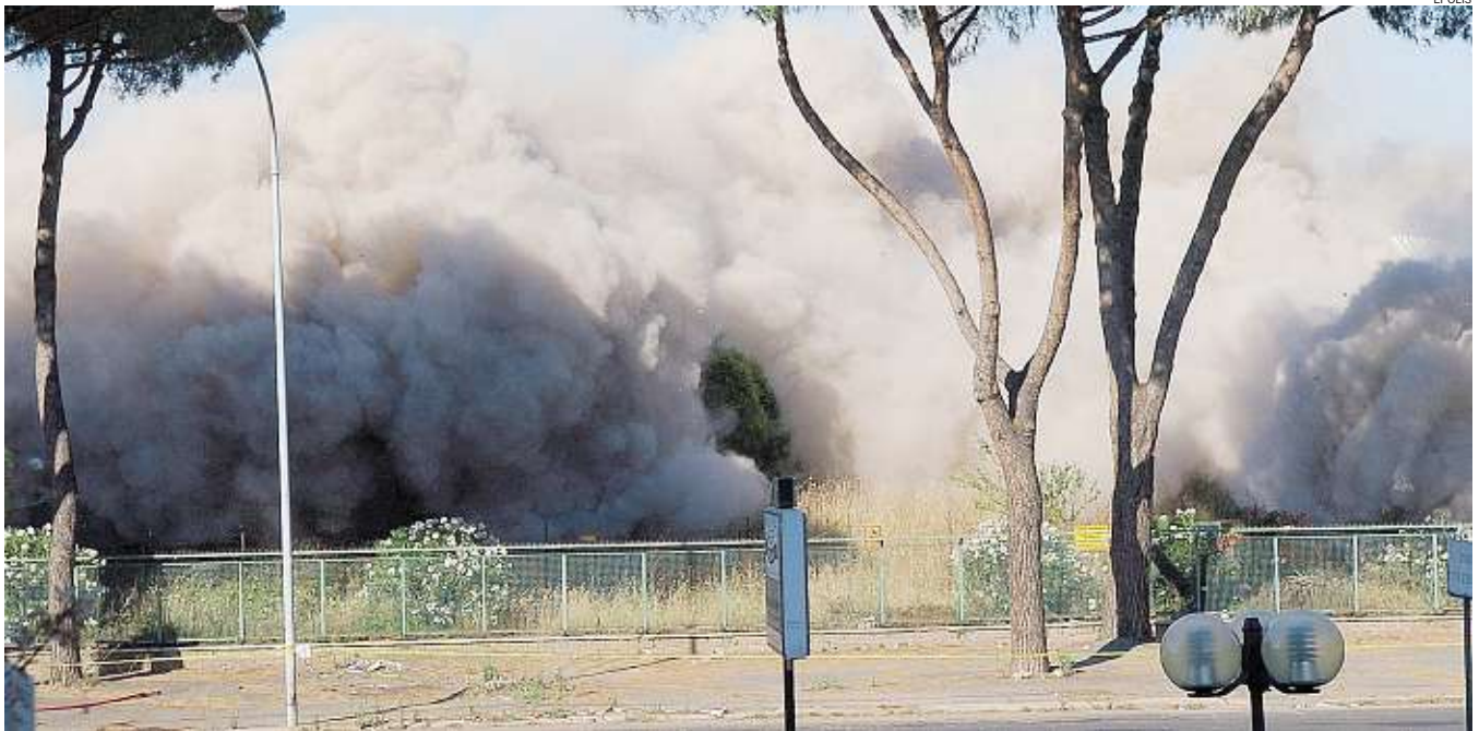
► La demolizione dell'ex Velodromo, nella zona del Torrino
